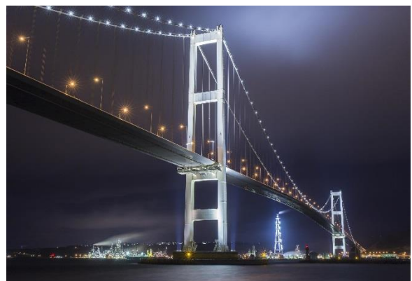
室蘭夜景観光として親しまれている白鳥大橋のイルミネーションライトアップ LED化(H29年度完了予定)
