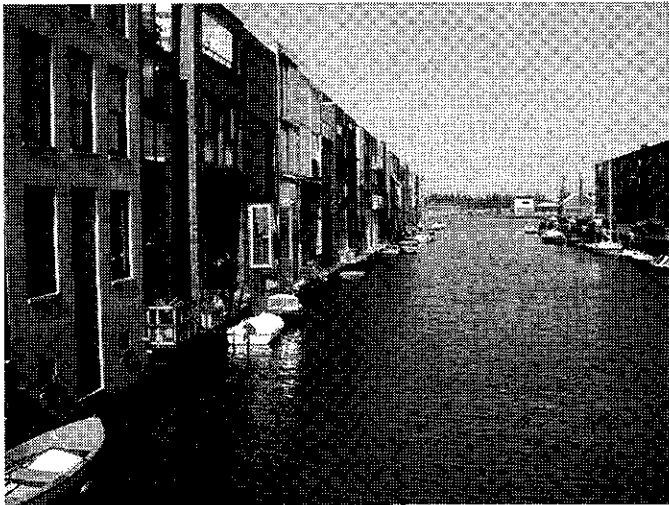
水辺の魅力を活かした住宅の建設が続く (アムステルダム市ボルネオ地区)
