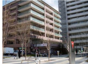
正面左側がベルパージュ大阪上本町が入居するウェルライフ上本町
