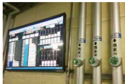
【地下階／画面による一括管理システム】
