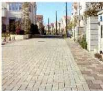
道路の舗装 保水舗装 陶器瓦版や高水砕スラグ等を利用したリサイクル材、照り返し抑制及び保水機能を持ち気化熱を利用し周辺の気温を下げる
