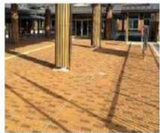
緑道の舗装 木質舗装材ブロック 景観の調和を考慮したリサイクル材、照り返し抑制及び保水機能を持ち気化熱を利用し周辺の気温を下げる。また木の弾力が歩行時の足腰への負担を軽減する
