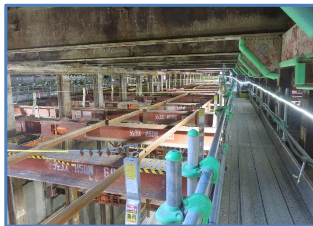
B1階上層スラブ（写真上側）
