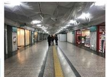
天井改修中の地下街
