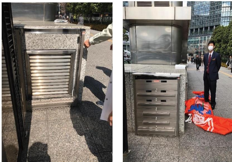
写真4.1.6 左：止水板取付前
