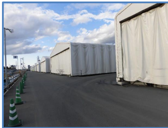
写真6 和光の土砂仮置き場
