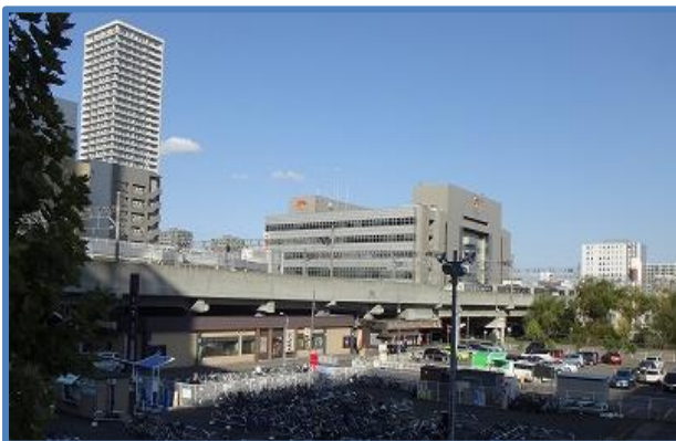
写真3 北5西1北側街区の現況
