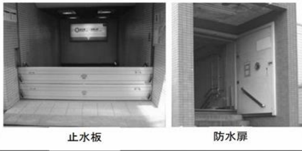
地下駅出入口
